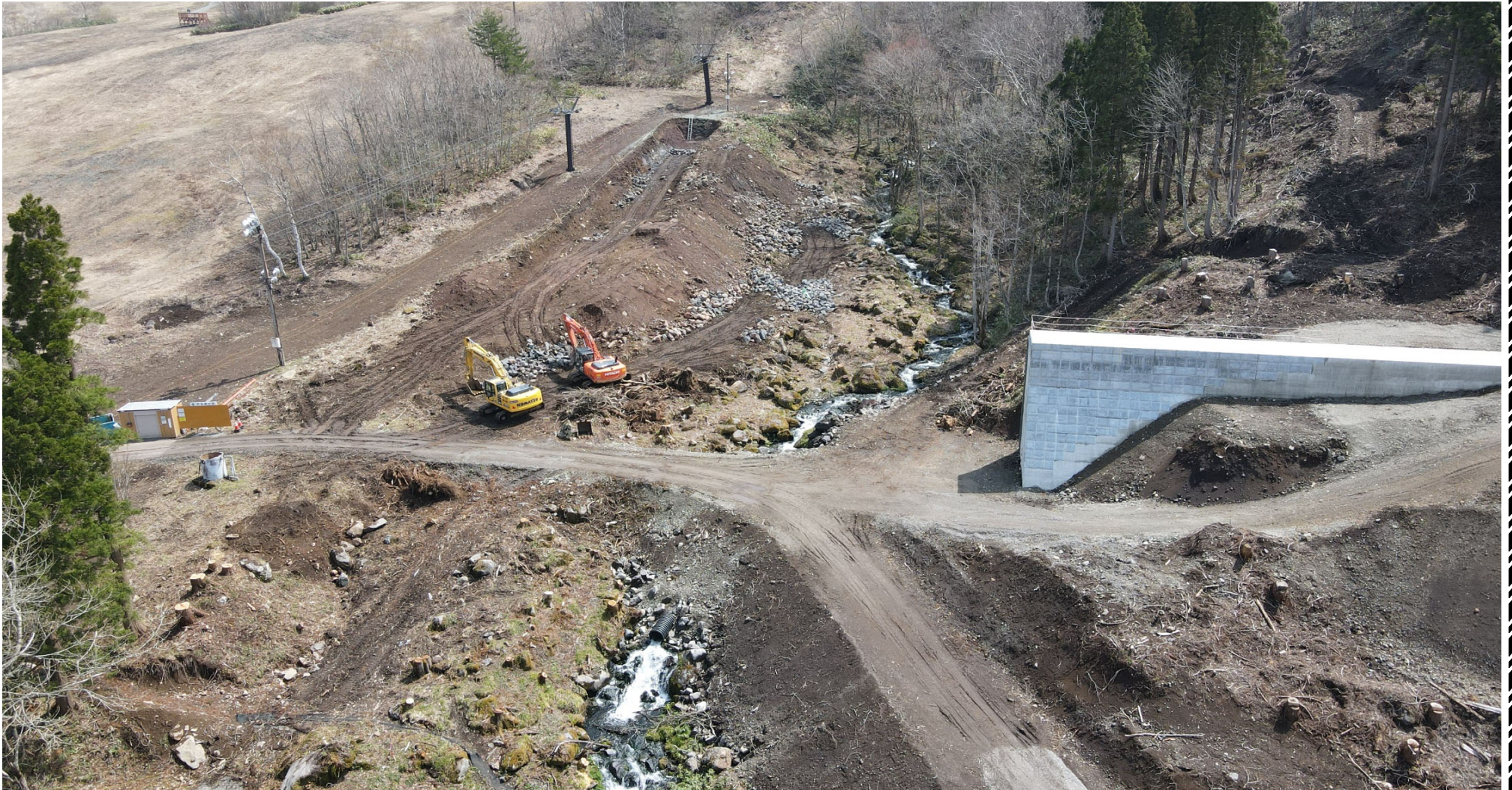
ICT機械による掘削作業
