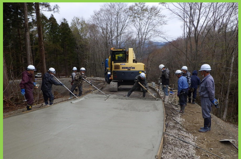
管理用道路のコンクリート舗装
