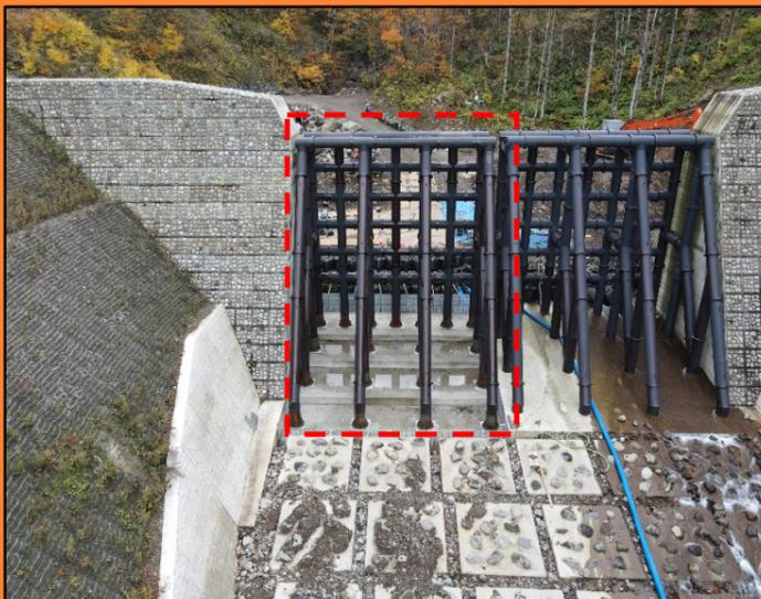
上の写真の破線の囲みが今年の施工範囲で右側と同じものを作っています。
