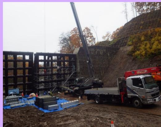
鋼製堰堤の組立てが終わり足場を解体している状況です。
