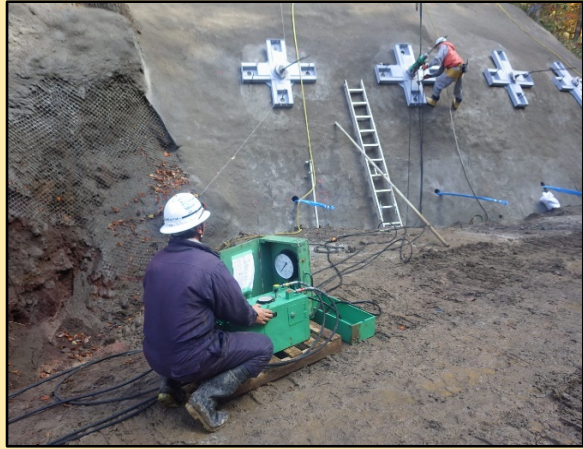
アンカーを緊張している状況です。 アンカーの縮む力を利用して地山を押さえつけます。
