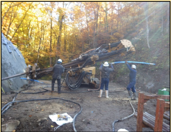
アンカーを挿入している状況です。 アンカーは長いもので11mあります。
