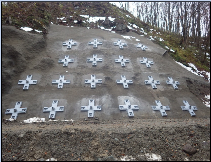
グラウンドアンカーを4段施工しました。
