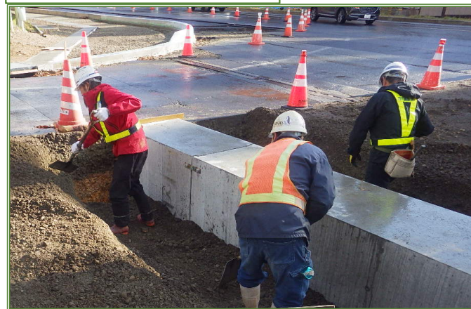
県道交差点付近での工事の様子
