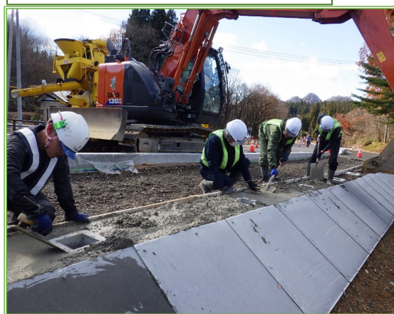
パネルの設置、生コン打設の様子
