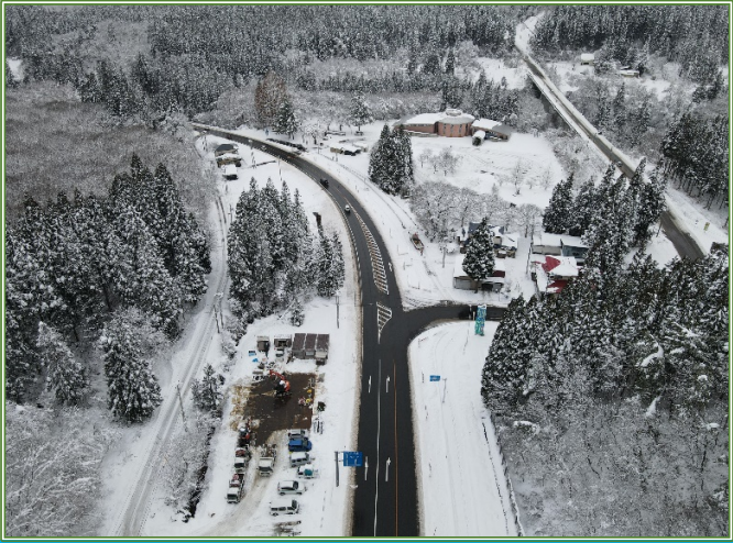
工事終了時の荒川地区の様子
