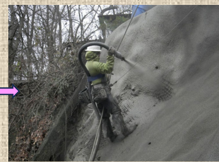
法面工（モルタル吹付）
