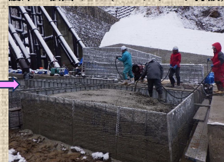
護床・根固め工（コンクリート打設）
