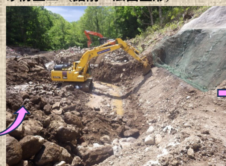
砂防土工（掘削・法面整形）
