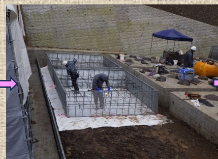
護床・根固め工（型枠組立）
