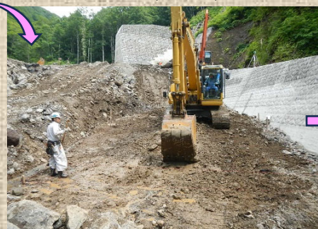
護床・根固め工（床掘り）
