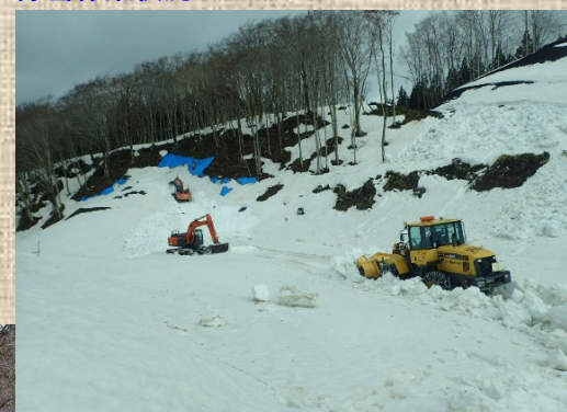
除雪作業状況
