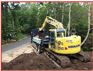
蟹沢へ土を移動しています。
