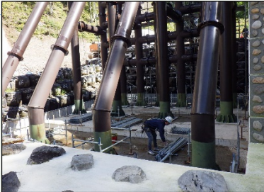
⑩ 足場解体
