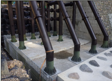
⑪鉄筋組立（2次施工）※準備中
