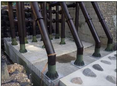
⑪鉄筋組立（2次施工）※準備中
