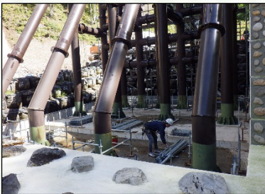
⑩ 足場解体
