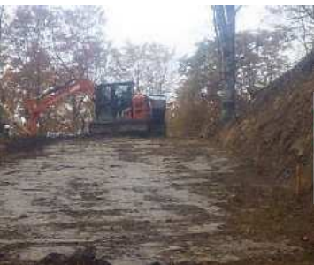
盛土を進めています。
