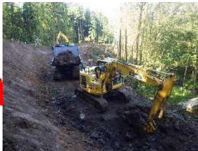
土の移動も終盤です。
