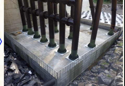
⑫型枠組立（2次施工）
