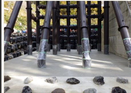
⑭コンクリート養生（2次施工）
