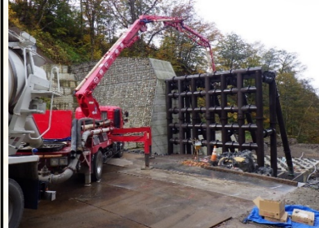
⑬コンクリート打設（2次施工）
